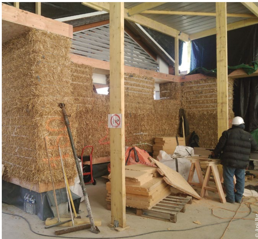
Construction en paille porteuse d'un groupe scolaire à Rosny-sous-Bois en 2017.
